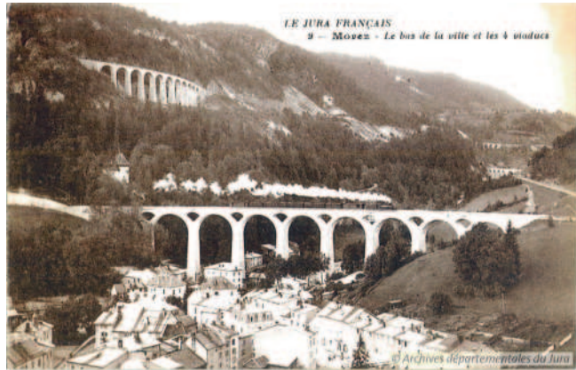
Figure 1.23. Carte postale ancienne : « le Jura français, Morez, le bas de la ville et les 4 viaducs ». Source : archives départementales du Jura
