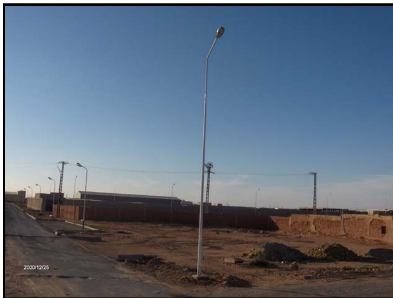
Photo n° 22. La zone industrielle d'Adrar : une faible densité des unités industrielles
