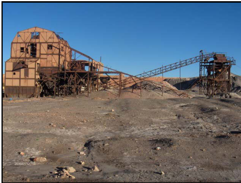
Photo n°15. Edifices de la houillère de Kenadsa (2008)
