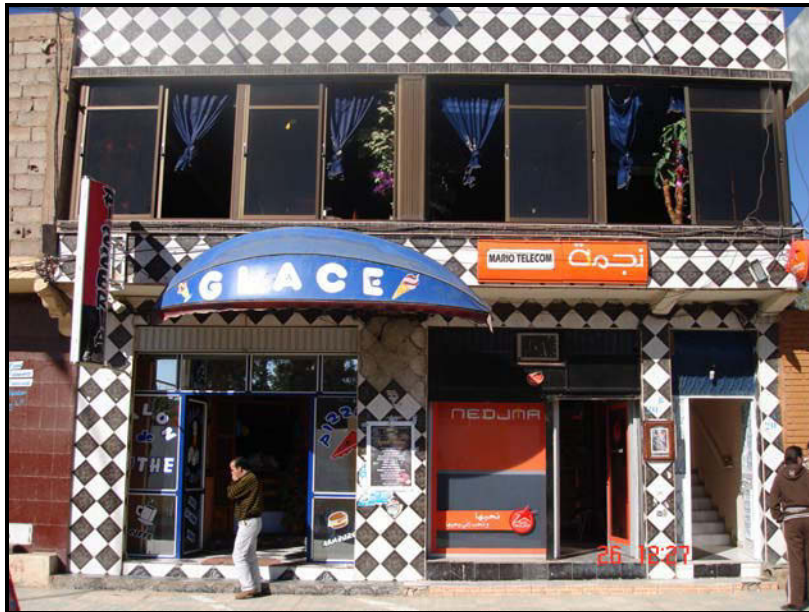
Photo n°20. Modernisation des locaux commerciaux et développement des services (téléphoniques, restauration) à Bechar
