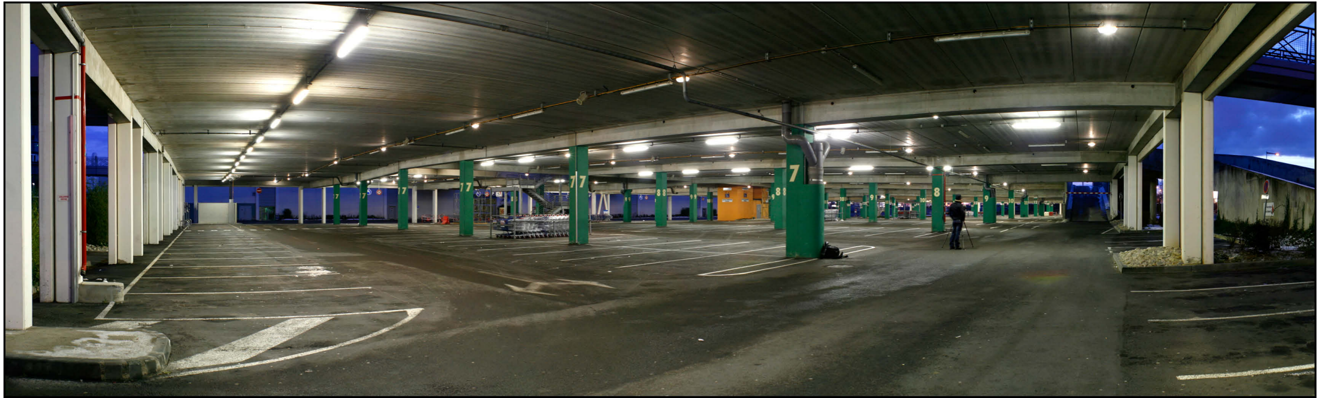
Photographie 37 : Parking de grande surface restant éclairé toute la nuit pour raisons de sécurité. Zone commercial de Quétigny (à proximité de Dijon). © Samuel CHALLEAT, 2010.
