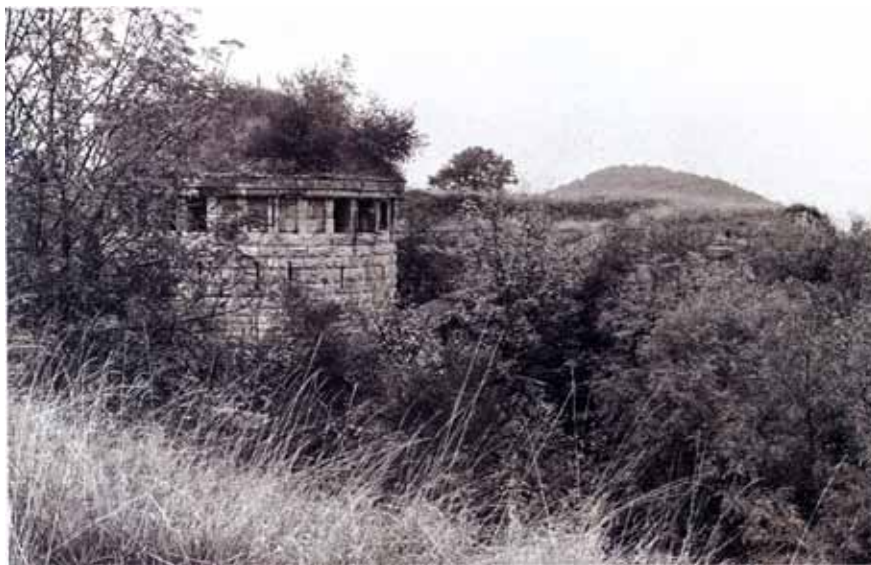
Au fort de Chaudanne, la partie non démolie de la lunette d'Arçon achevée sous la Seconde Restauration. Il s'agit de la tour-réduit semblable (sauf le toit) à celle subsistant à Trois-Châtel.
