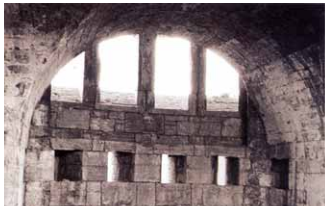
La lunette de Trois-Châtel : intérieur de la tour-réduit, au premier étage
