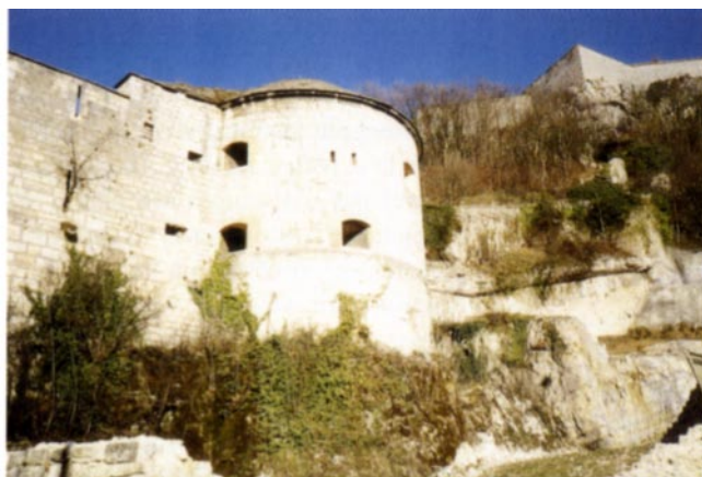
Les abords de la porte Notre-Dame. Cliché P. Delsalle
