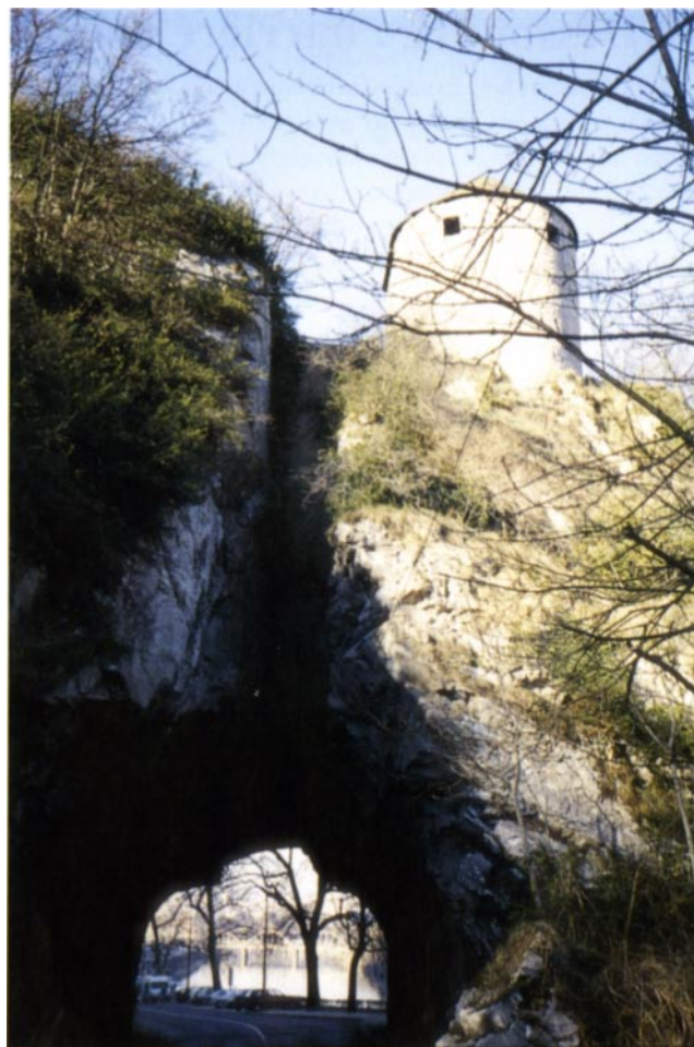
La porte Taillée. Cliché P. Delsalle
