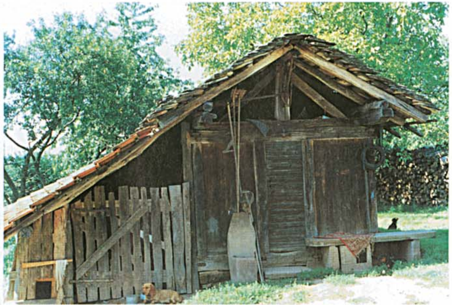
Un chalot sous bonne garde, Fougerolles (cliché J.Galmiche)
