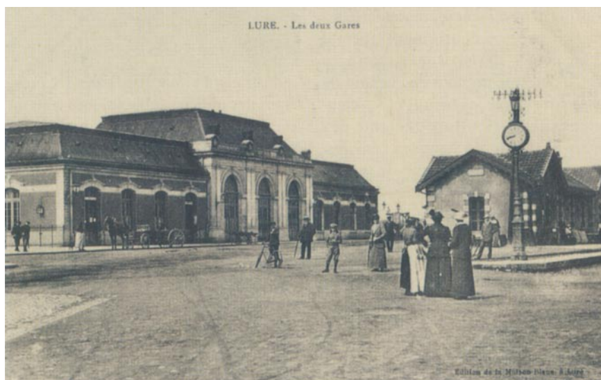
Lure : les deux gares. À côté de la gare de la Compagnie de l'Est (Paris-Belfort), la petite gare et les quais de la gare des chemins de fer vicinaux.
