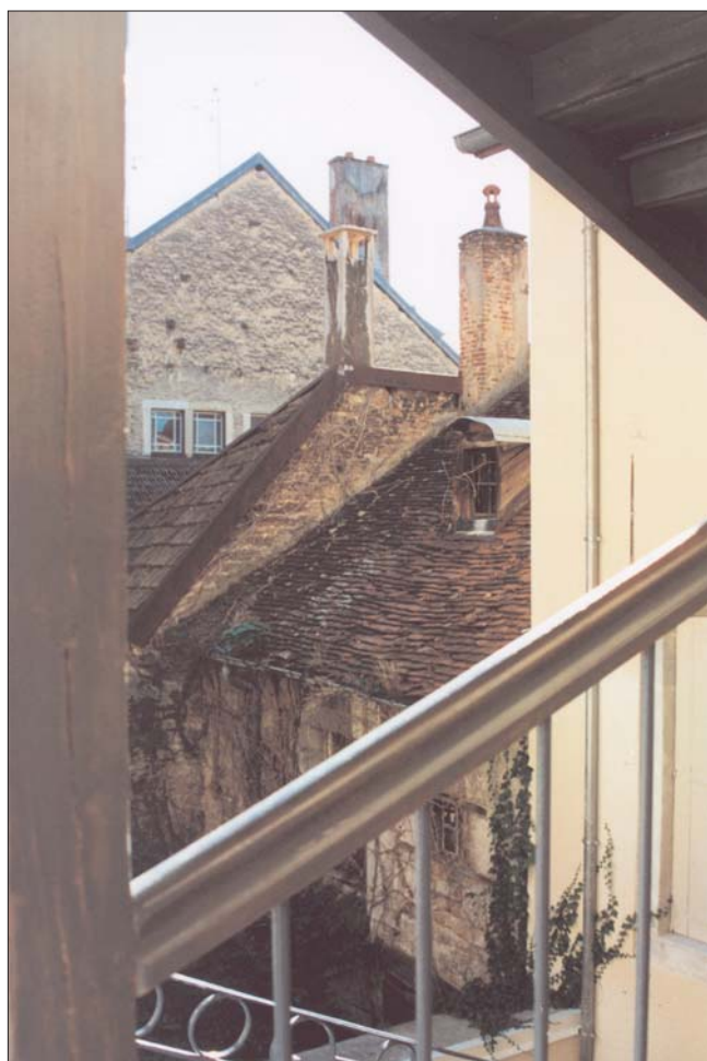
Photo 1 - Rue Lafayette, SOGEPRIM ; partie non rénoverée (cliché : A. Gloor)
