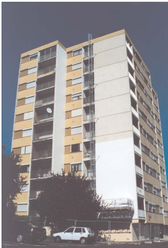
Photo 4 - Immeuble du quartier de la Marjorie, rue Ripley (cliché : A. Gloor)
